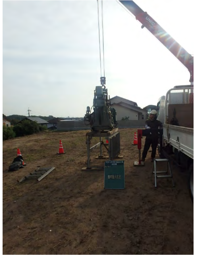
機材搬入状況
